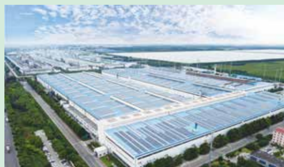
魏桥创业集团建设的屋顶分布式光伏发电项目。
