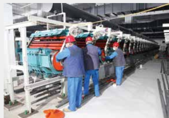
项目工地现场。
